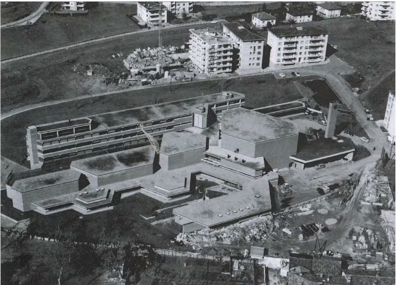
Veduta dall'edificio a cantiere appena concluso. (Lugano, Archivio della Radio della Svizzera Italiana).
