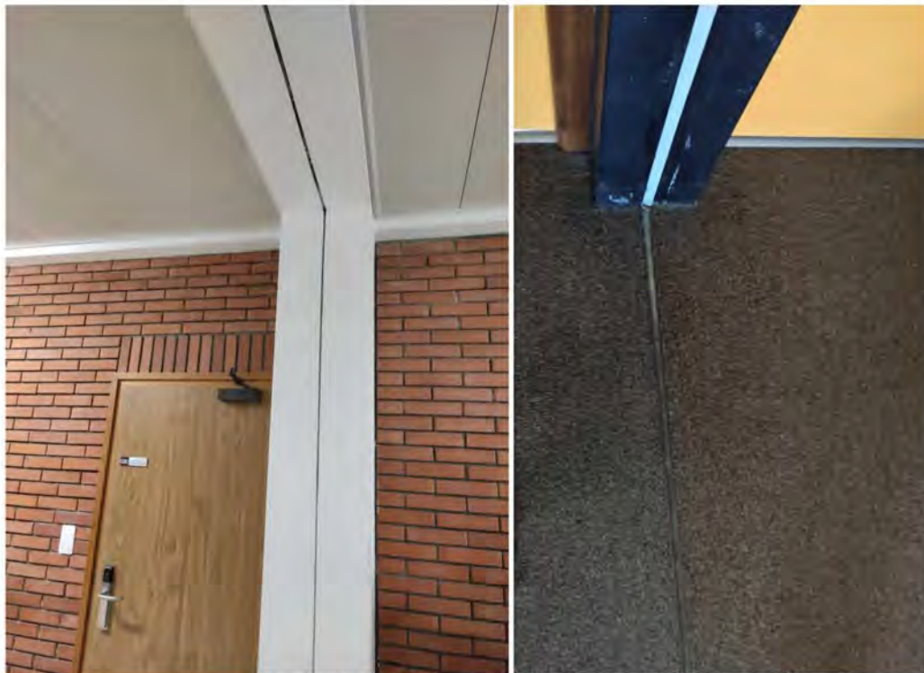
Fig. 13 e 14: giunti strutturali al piano interrato e al piano primo
