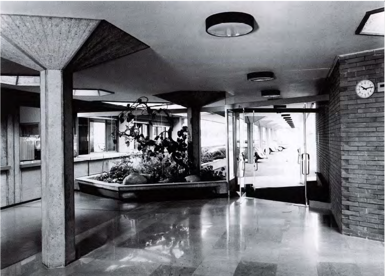
Nuovi studi della RSI, veduta dell'atrio di ingresso principale.
